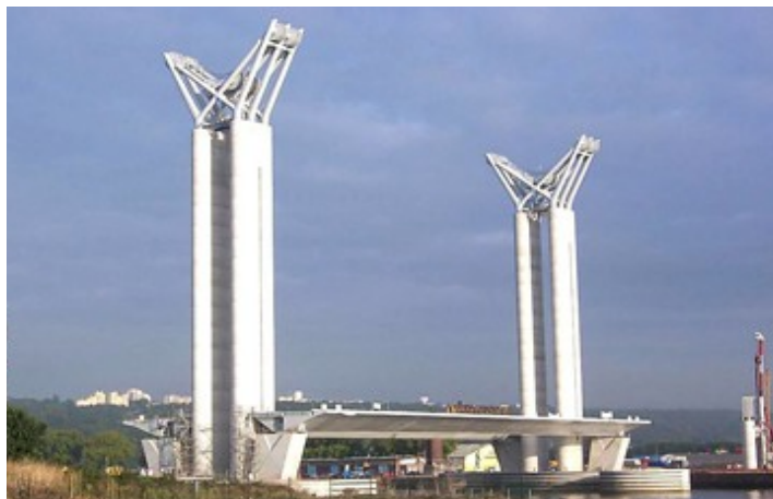
Fig. 1: Le pont levant Gustave Flaubert à Rouen construit par Victor Buyck Steel Construction
